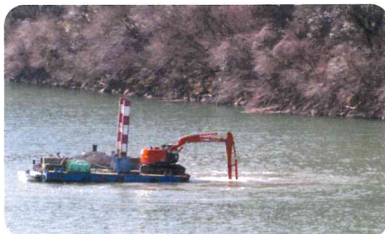
PDバックホウ船しゅんせつ作業
