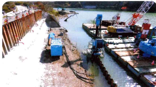
PDバックホウ船しゅんせつ作業
