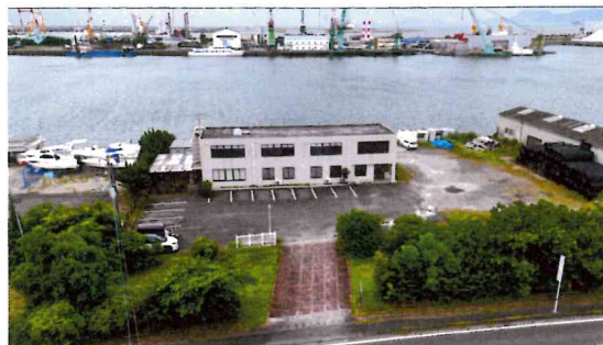
PDクレーン船(西部護岸補強作業)
