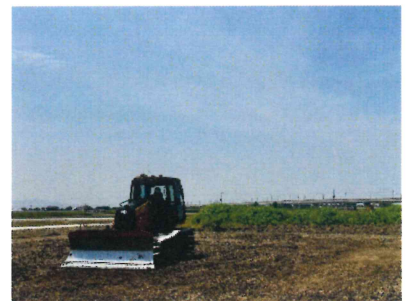
ICTブルドーザでの施工状況
