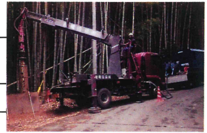
岩盤掘削車を使用しての作業
