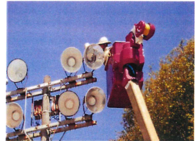
高所作業車を使用しての作業
