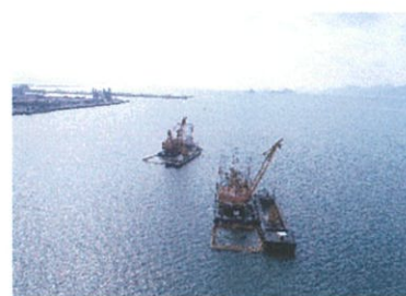
浚渫船を利用した港湾工事
