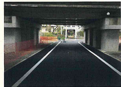
国道266号（鯉避溢橋） 道路補修補助事業（橋梁）下部工事
