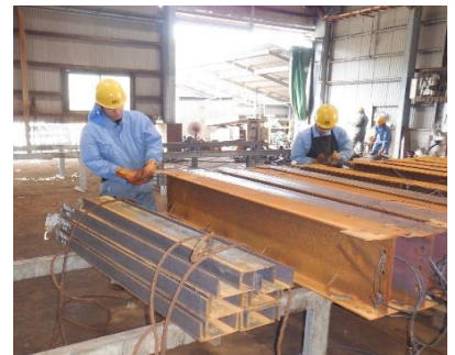
工場内作業写真2
