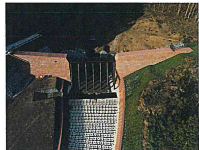
完成した堰堤工事
