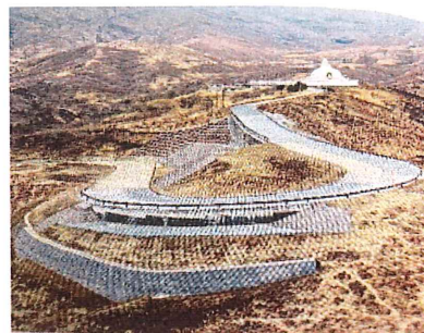
平成31年3月竣工写真
