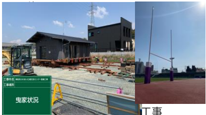
【右写真】水前寺競技場アメフトゴールポスト設置工事
