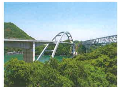
当社の手掛けた橋梁（天城橋）
