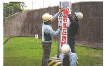
現場での作業例
