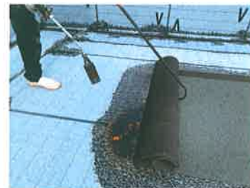
アスファルト防水工事の様子
