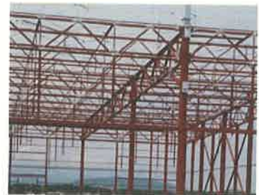
トラスと呼ばれる梁
