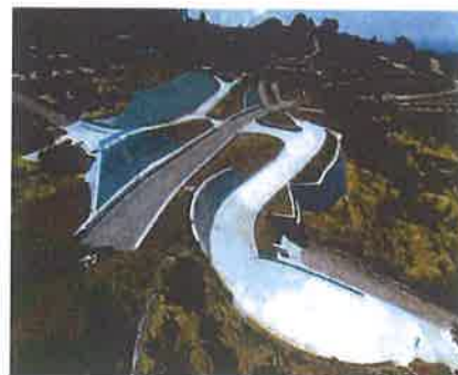
施工工事写真
