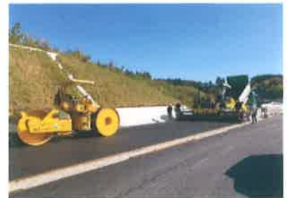
舗装工事の様子
