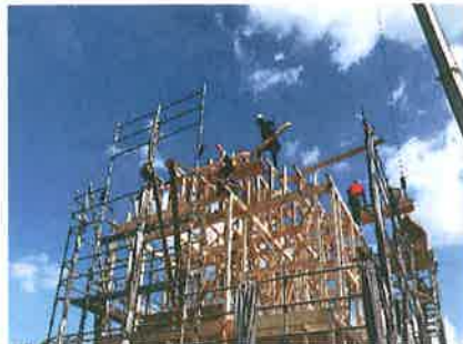
棟上げ工事の様子
