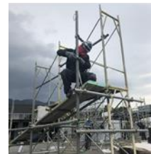
足場仮設工事
