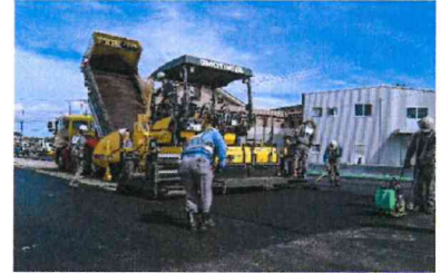
舗装工事の様子
