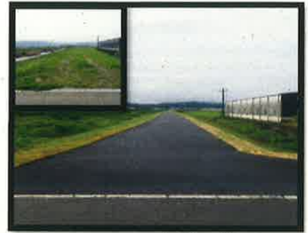
現場の工事前・後
