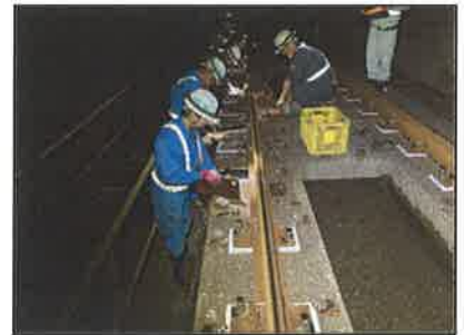
夜間作業の様子
