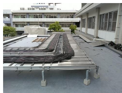
施工した芦北地域振興局での工事
