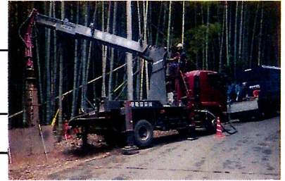
岩盤掘削車を使用しての作業
