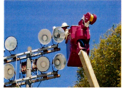
高所作業車を使用しての作業
