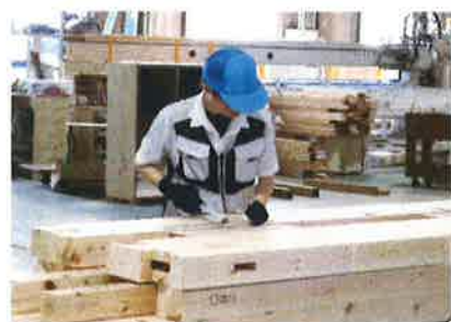
プレカット工場作業風景
