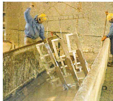
工場内作業写真1
