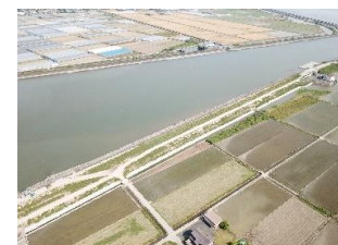
堤防盛土工事 着工前
