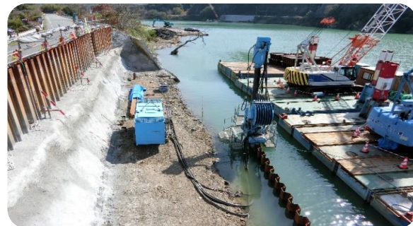
PDバックホウ船しゅんせつ作業
