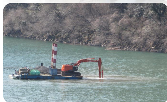
PDバックホウ船しゅんせつ作業
