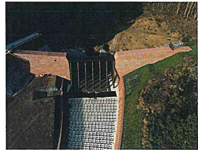
完成した堰堤工事
