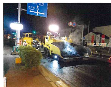
舗装工事の様子
