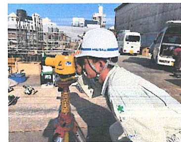
マンション新築現場の作業風景
