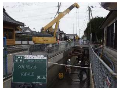
直営作業状況（水路工事）
