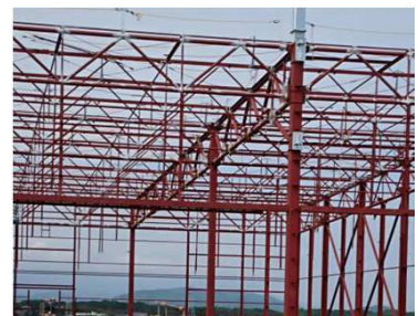
トラスと呼ばれる梁
