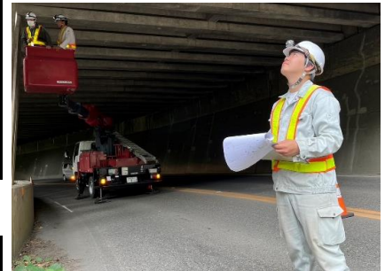
橋梁点検作業
