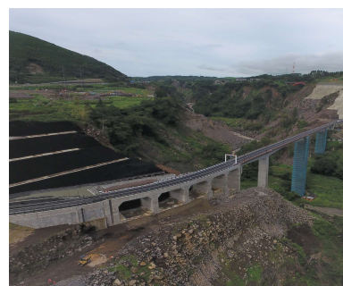
完成現場様子
