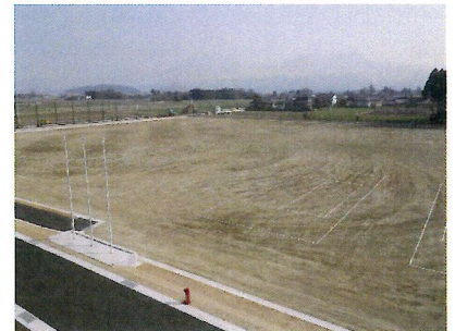
現場（グラウンド施工）
