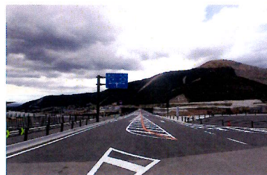
施工実績（熊本325号阿蘇大橋地区改築工事）
