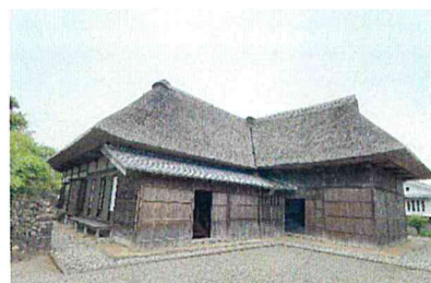
修復作業をした重要文化財太田家住宅
