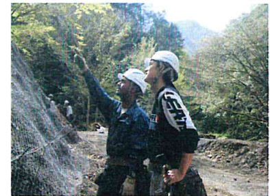
現場での打ち合わせ風景
