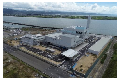
工事現場の様子（外構施工）
