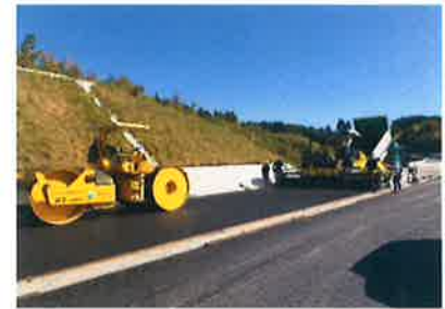
舗装工事の様子
