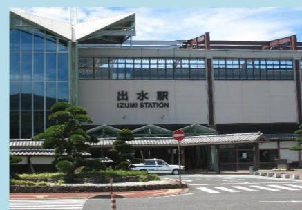
出水駅周辺施設
