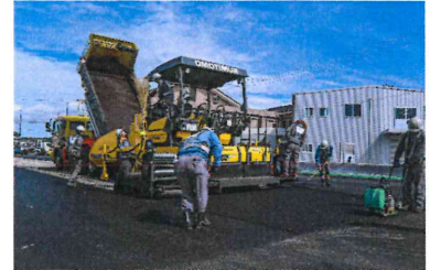
舗装工事の様子
