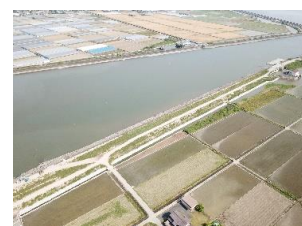
堤防盛土工事 着工前
