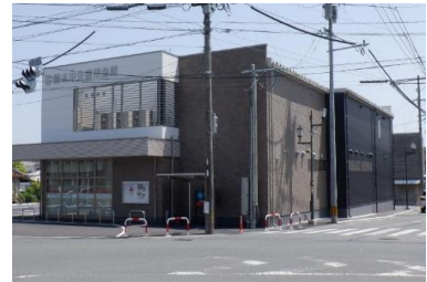
熊本中央信用金庫玉名西部支店新築工事 (場所：玉名市亀甲)
