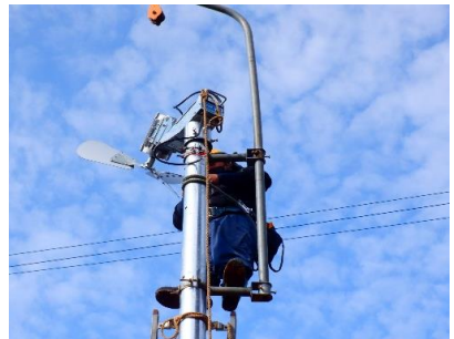
防霜ファン工事風景
