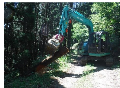
現場での作業の様子
