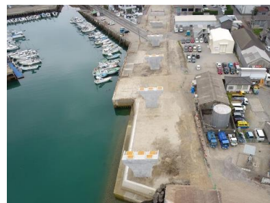
完成した橋脚工事
