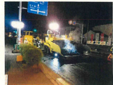
舗装工事の様子
