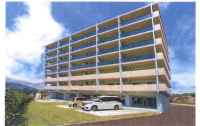
(実績) 災害に強い大規模マンション
