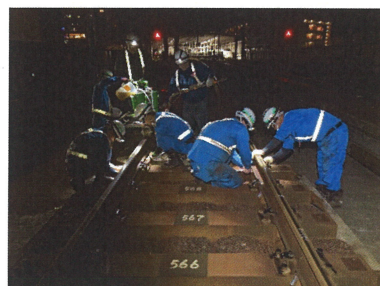
夜間作業の様子
