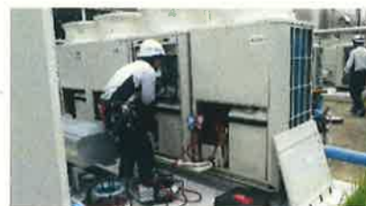
空調機試運転作業の様子
