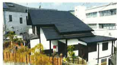
古民家をリノベーションした3階建て社屋
